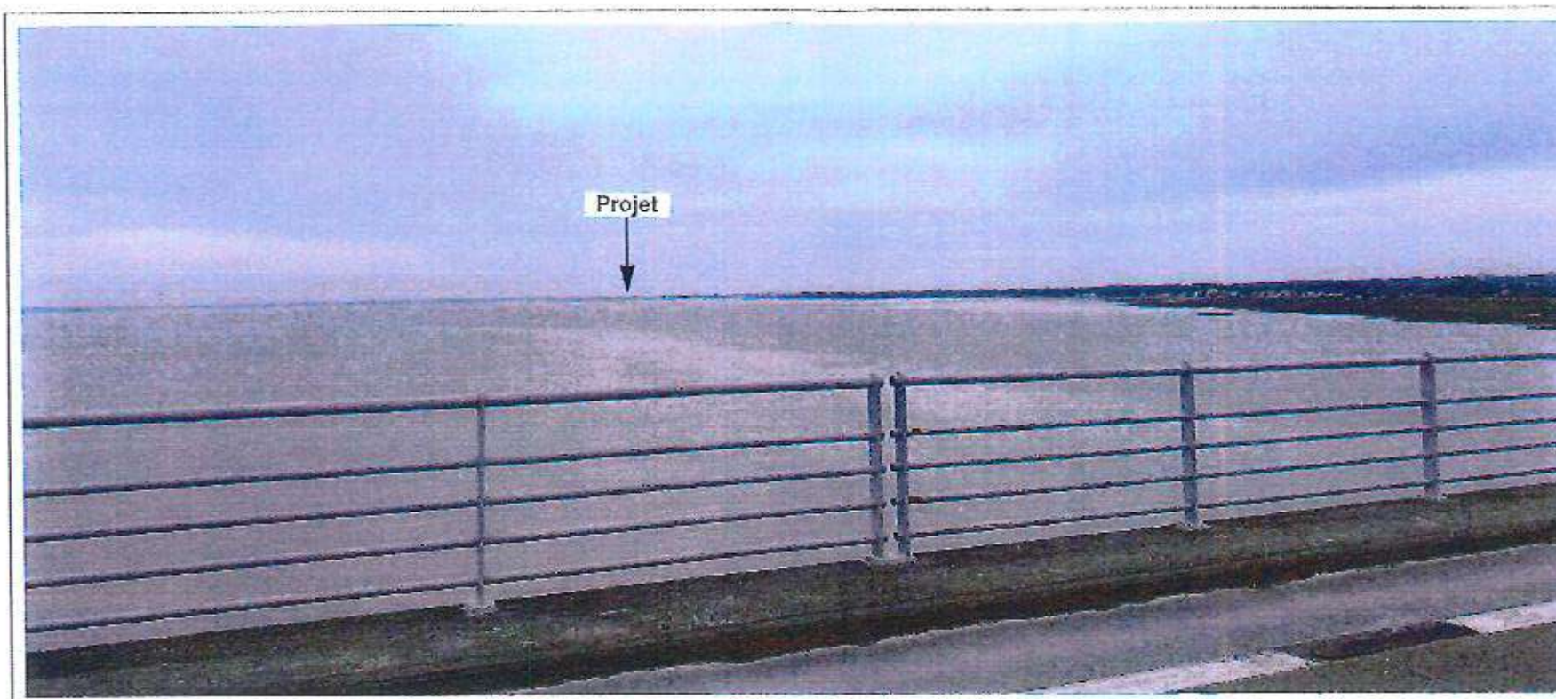
Vue 1 - Photo du Viaduc de la Seudre
