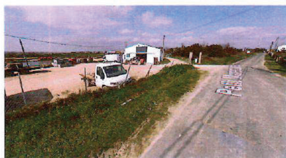
Vue 3 - proche - AVANT TRAVAUX
