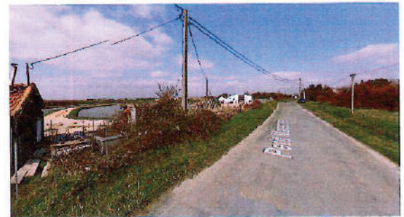
Vue 4 - lointain - AVANT TRAVAUX
