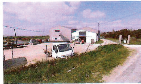
INSERTION - Vue 1 - APRÈS TRAVAUX
