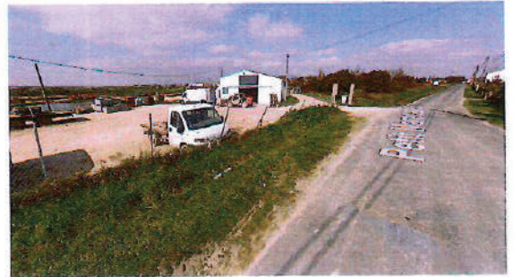
Vue 3 - proche - AVANT TRAVAUX
