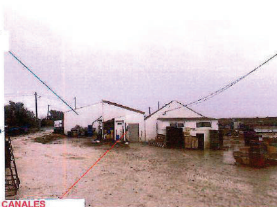
TOITURE TUILES ROMANES CANALES DÉMOLITION D'UNE PARTIE DES BÂTIMENTS EXISTANTS AFIN DE RÉHABILITER LES BÂTIMENTS
