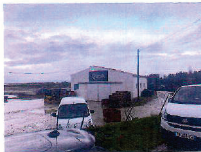
Vue 2 - proche - AVANT TRAVAUX
