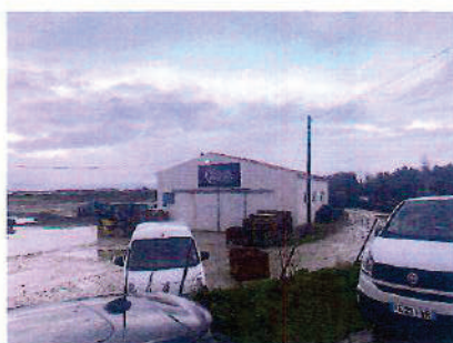
Vue 2 - proche - AVANT TRAVAUX
