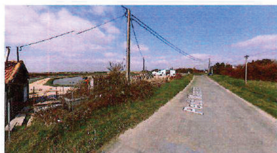
Vue 4 - lointain - AVANT TRAVAUX
