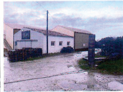
INSERTION - Vue 2 - APRÈS TRAVAUX
