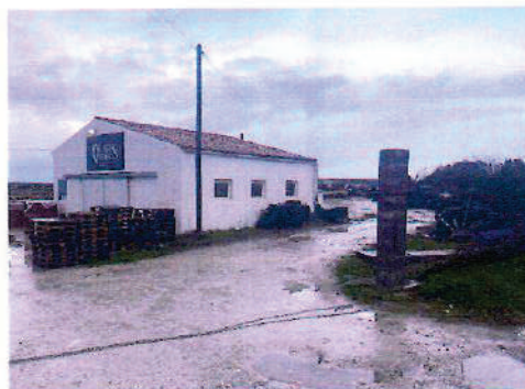
INSERTION - Vue 2 - proche - AVANT TRAVAUX
